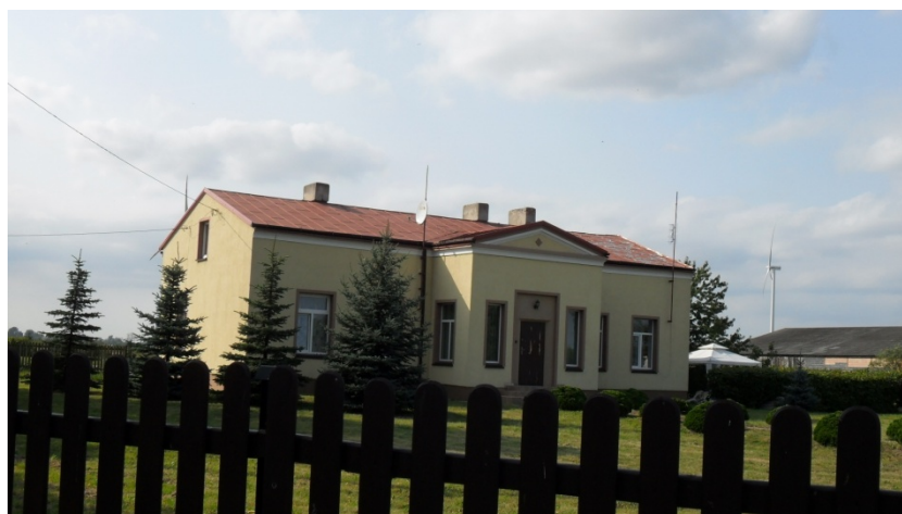
Rysunek 15. Murowana plebania znajdująca się w sąsiedztwie kościoła w Raczyńcu.
