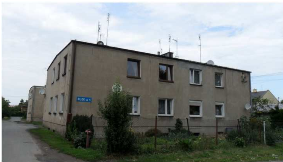
Rysunek 2. Zabudowa wielorodzinna dwukondygnacyjna zlokalizowana na terenie byłego PGR-u w Czarnożyłach.
